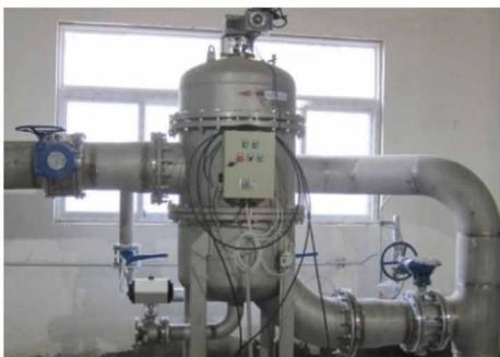
南京博滤工业 AFC 全自动反冲洗过滤器，适用于高流量、高流速、低粘度液体过滤场合。本产品为机电一体化设计，具有设计合理、过滤效率高、运行成本低、反洗过程中仍能连续过滤等优点，广泛应用于冶金、化工、电力、油田回注水，以及环保水处理等领域。
